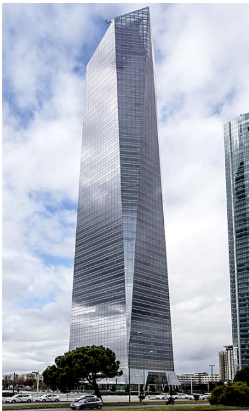
Torre de Cristal es uno de los edificios que comparte servicios en la red de MutuaCity. J. Valeiro
